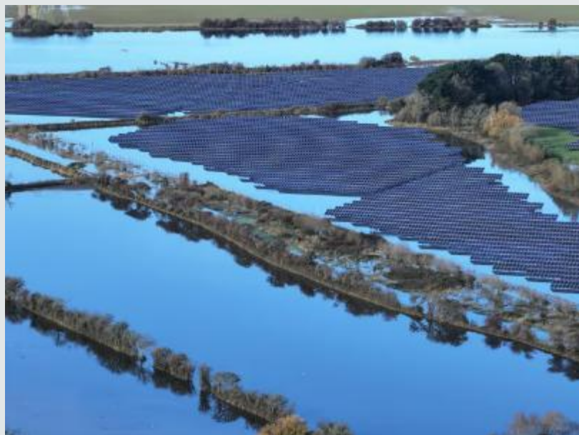
Alagamento em PV Solar Farm – England – fonte Sussex Word
