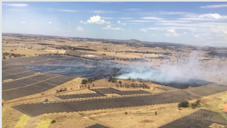
Incêndio Florestal na Australia afeta a Planta Fotovoltaica fonte abac
